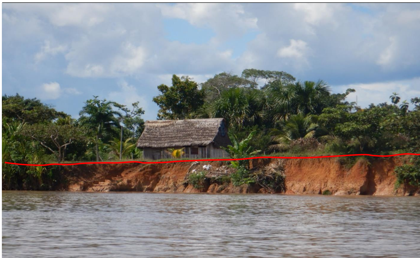
FIGURA N°01: LAS VIVIENDAS ASENTADAS PARALELAMENTE AL CURSO DEL RÍO, YA SE ENCUENTRAN MUY CERCA AL CAUCE, EN CONDICIONES DE RIESGO POR EROSIÓN DEL SUELO.
